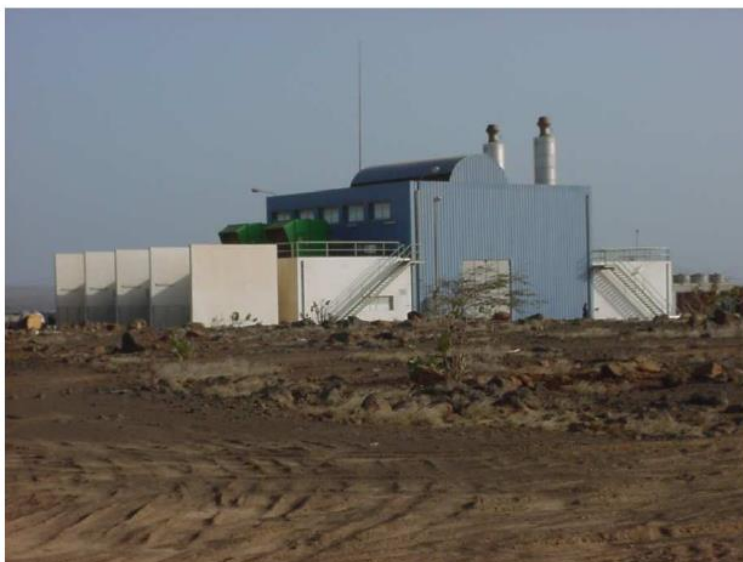
Figura 3 - Central elétrica da Palmeira.
