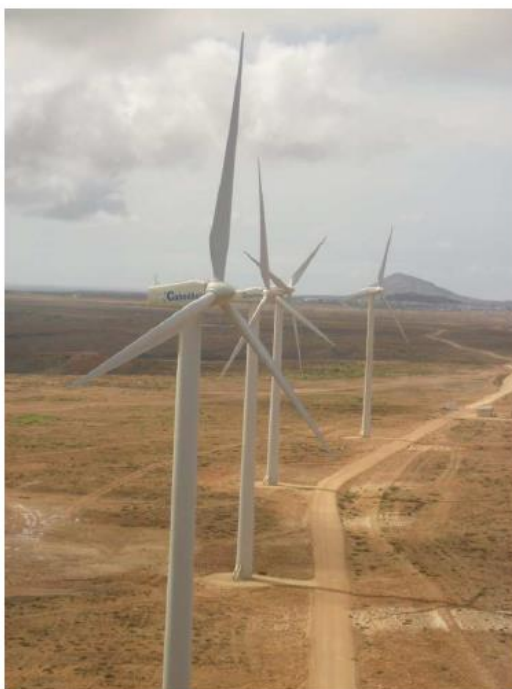
Figura 5 - Parque Eólico de Lajedo de Ribeira de Tarrafe
